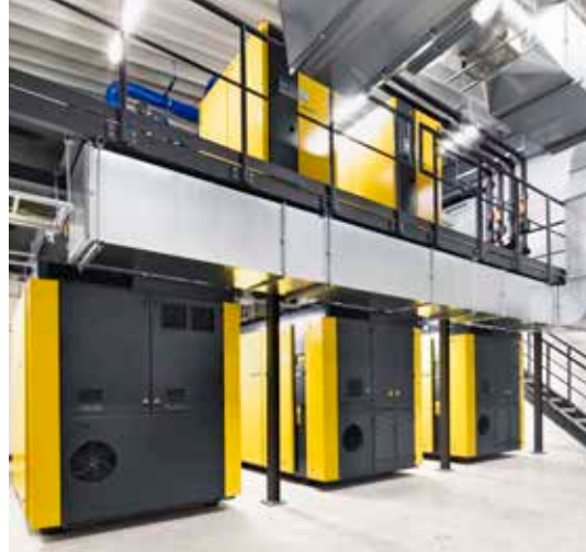
Foto vlevo: V těchto impozantních extrudérech se vyrábí obrovské fóliové pásy. Foto vpravo: Nová kompresorová stanice je z prostorových důvodů uspořádána ve dvou úrovních.
