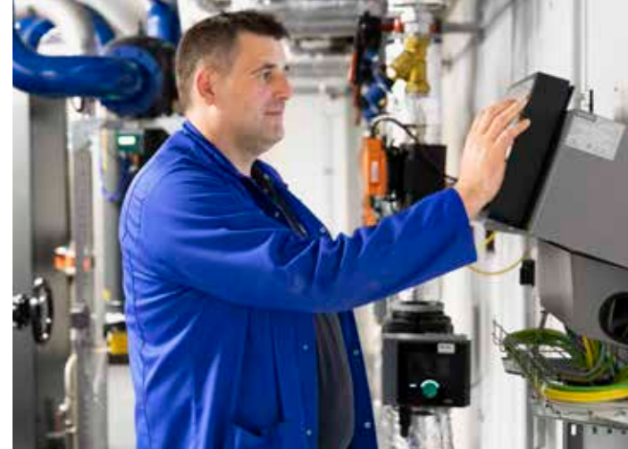
SIGMA AIR MANAGER 4.0 zajišťuje prostřednictvím řízení stlačeného vzduchu co nejlepší vytižení jednotlivých kompresorů a maximálně efektivní provoz celé stanice.
